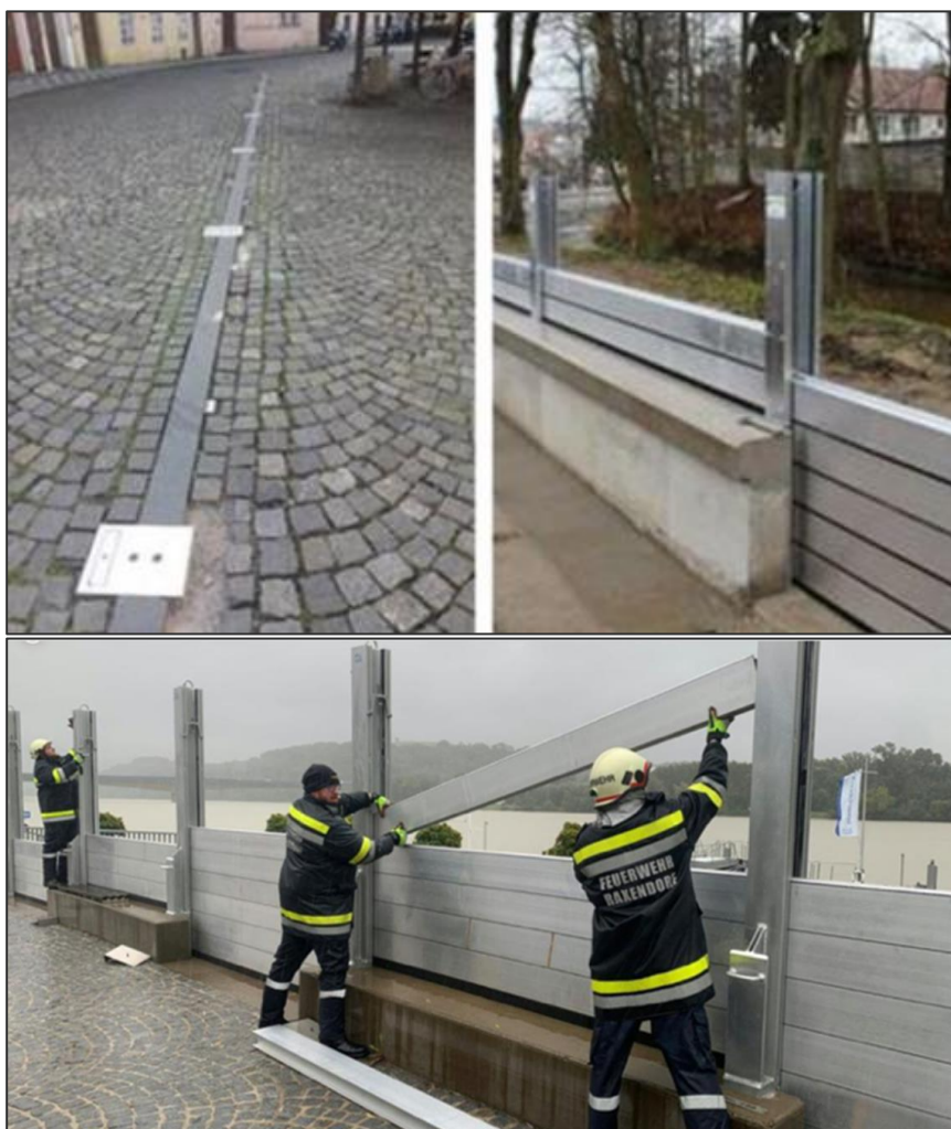
Figur 4.9 Øverst venstre: Bundplade og fundamenter til opsætning af skots med stolper og planker. Øverst højre: Betonmur, der er forhøjet med planker. Nederst: Opsætning af skots med planker ved Donau. Kilder: Kurier.at.
