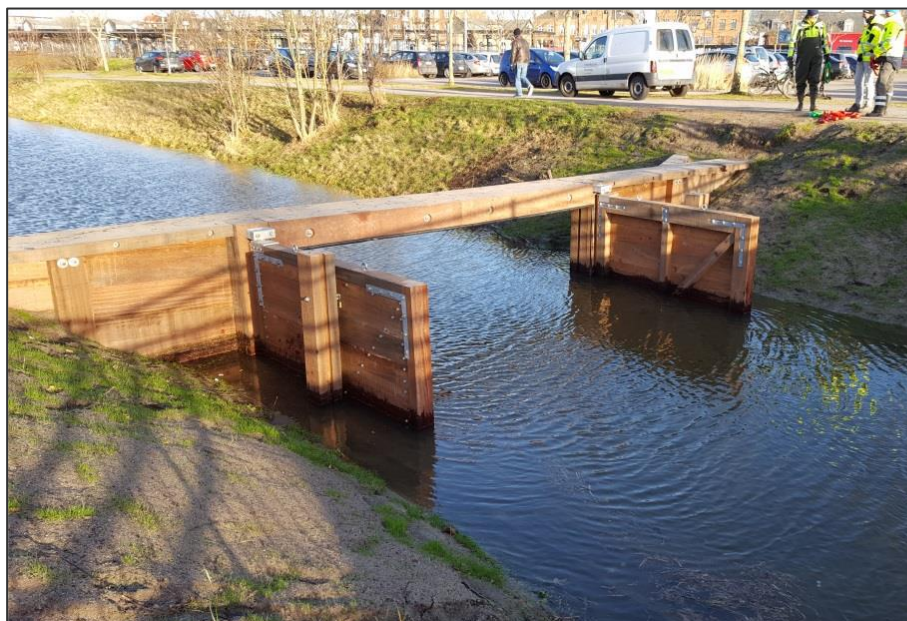
Figur 3.7: Eksempel på højvandslukke i hårdt træ med manuel betjening – her åbnet efter Urd-stormen i Frederikssund.
