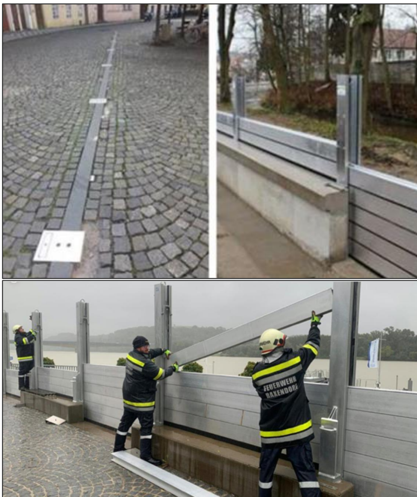
Figur 3.5: Øverst venstre: Bundplade og fundamenter til opsætning af skots med stolper og svinerygsplanker. Øverst højre: Betonmur, der er forhøjet med svinerygsplanker. Nederst: Opsætning af skots med svinerygsplanker ved Donau. Kilder: Kurier.at
