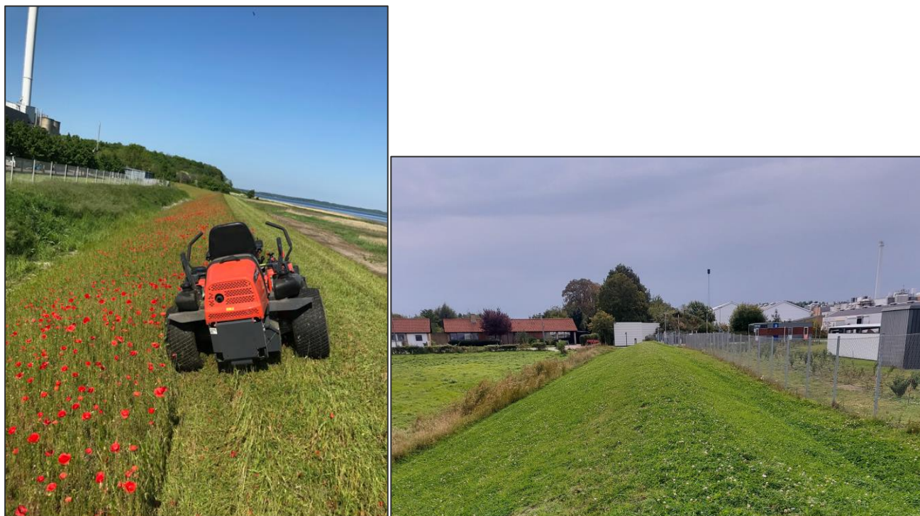
Figur 3.2: Til venstre: Græsslåning på dige ved Haldor Topsøe. Til højre: Samme dige ved Haldor Topsøe.
