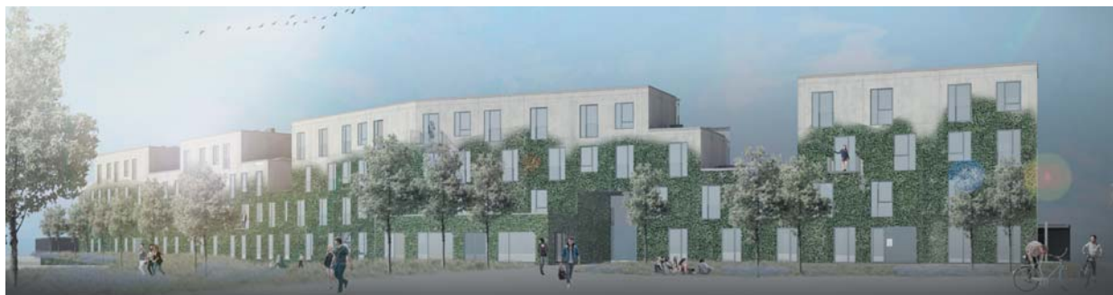
Facade mod Campus - hovedprojektet
