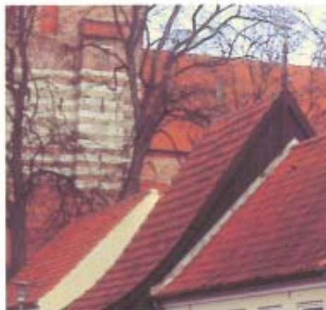
Gamle og nye tegltage i Kirkestræde "munke og nonner" på Danmarks ældste daterede bindingsværkshus fra 1527, Kirkestræde 20.
