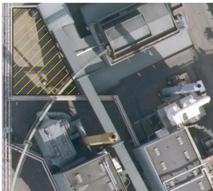
Figur 2: Placering af røggaskondenseringsanlæg på Køge Kraftvarmeværk.
